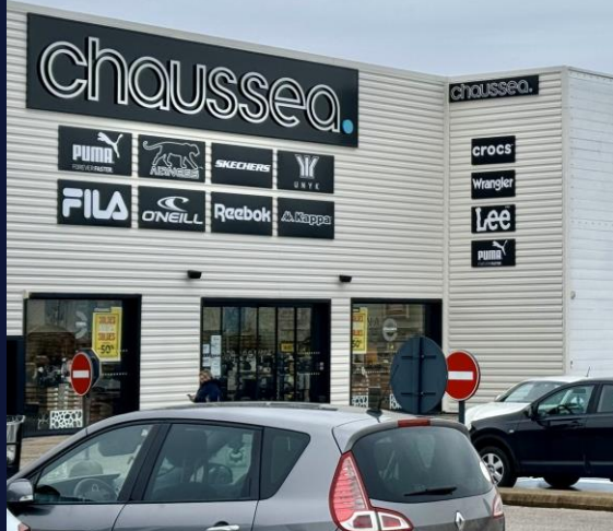
1500 m 2 Chaussée Dijon (21)
